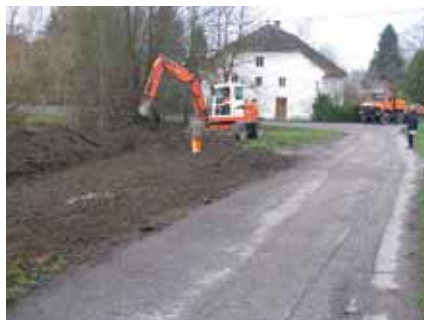
Bauarbeiten für den Parkplatz
