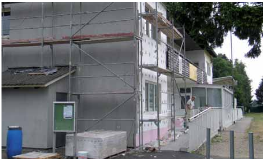
Die Sanierung des Sportheimes wird jetzt abgeschlossen
