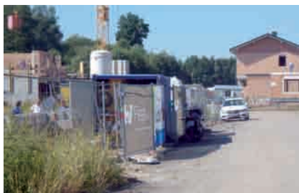
Ein Blick auf die im Bau befindlichen Einfamilienhäuser
