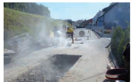
Kanalbau an der Alten Straße
